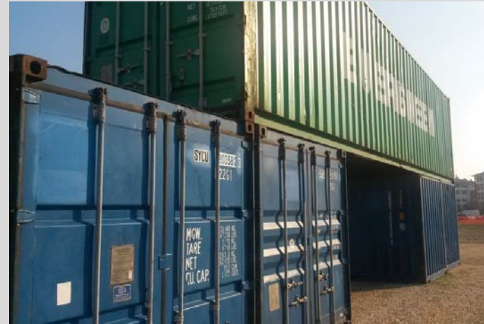
Assemblaggio in SITU – Zona Ristorante
